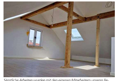
Sämtliche Arbeiten wurden mit den eigenen Mitarbeitern unseres Betriebs ausgeführt – vom Abbruch bis zum Anstrich. (danach)
