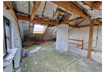
Seit 2020 führt der Malerbetrieb Tobias Richter auch fachgerechte Altbau-sanierungen durch. (vorher)
