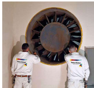
Beim Bauvorhaben Holdenried wurde die denkmalgeschützte Tür gründlich gereinigt und mit einer Metallkonservierungsbeschichtung versehen. FOTO: TOBIAS RICHTER
