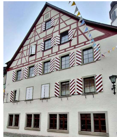
Der Malerbetrieb Tobias Richter saniert historische Gebäude in der Wangener Altstadt mit fachgerechter Handwerkskunst und hochwertigen Materialien. Diese Fassade „Altes Spital“ wurde von Tobias Richter 2024 renoviert. FOTO: TOBIAS RICHTER
